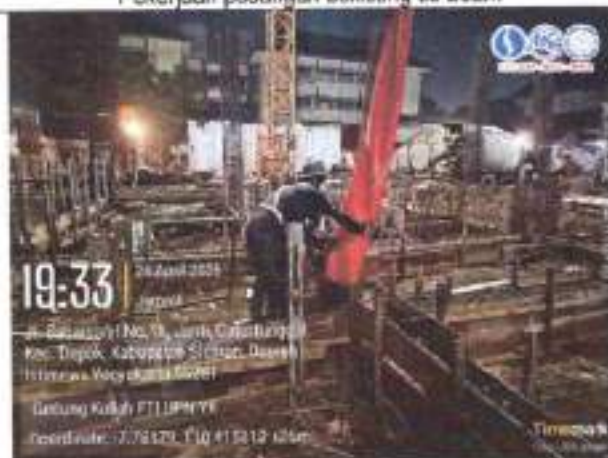
Pekerjaan pengecoran tie beam
