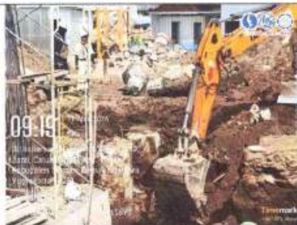
Pekerjaan galian pilecape
