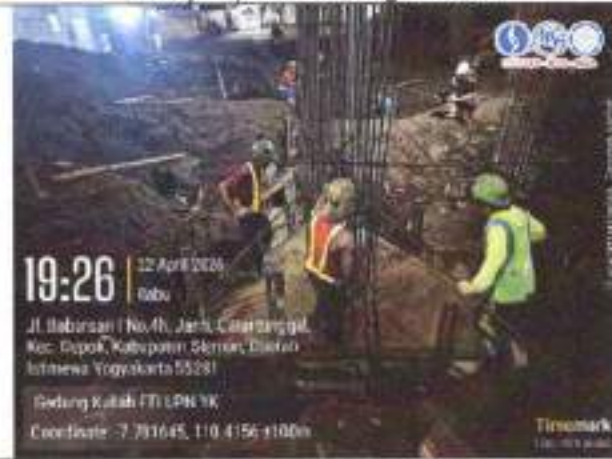
Pekerjaan pengecoran pilecap
