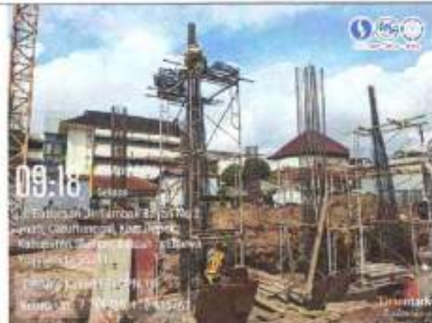
Pekerjaan pembesian sengkang kolom
