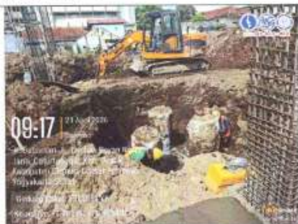
Pekerjaan chipping borepile
