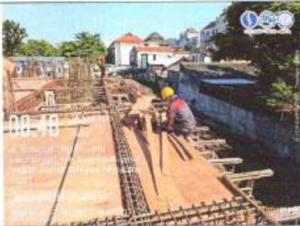
Pekerjaan bekisting plat lantai 1
