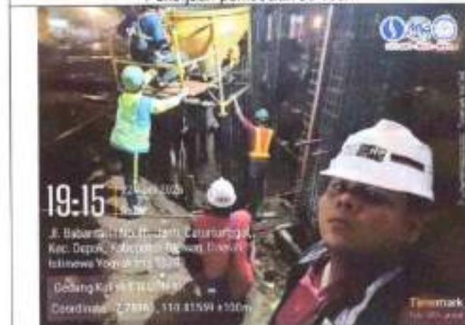
Pekerjaan pengecoran pilecap
