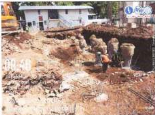
Pekerjaan chipping borepile
