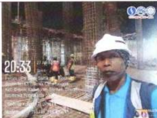
Pekerjaan pengecoran plat lantai dasar
