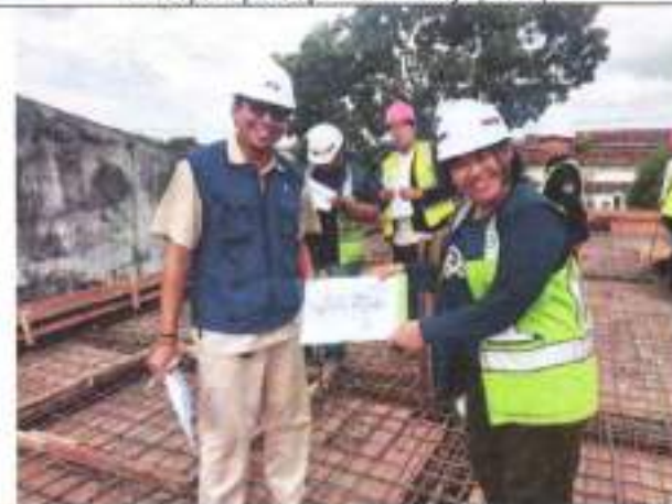
Ceklist bersama pada pekerjaan pembesian plat dan balok lantai 1
