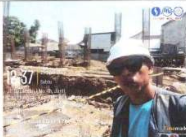
Pekerjaan lantai kerja pilecape
