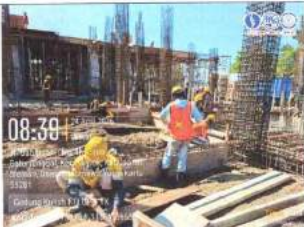
Pekerjaan pasangan bekisting tie beam
