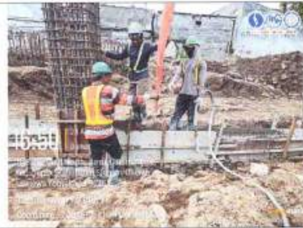
Pekerjaan pengecoran tie beam
