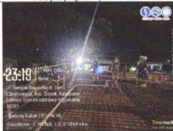
Pekerjaan pengecoran plat dan balok lantai 1
