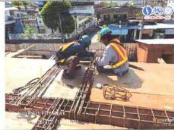
Pekerjaan pembesian balok lantai 1
