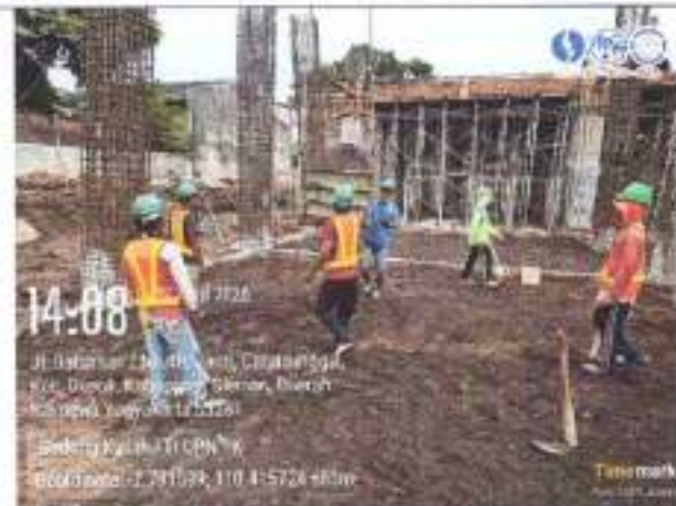
Pekerjaan penaburan pasir lantai dasar
