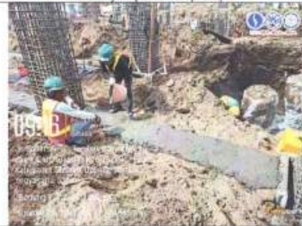
Pekerjaan lantai kerja tie beam
