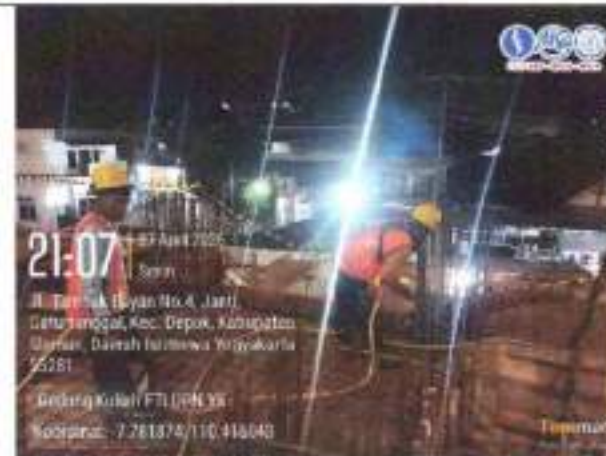
Pekerjaan pembersihan plat dan balok lantai 1
