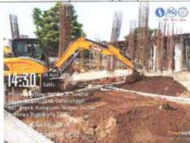
Pekerjaan urugan tanah lantai dasar
