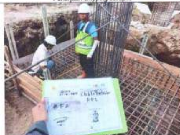
Pekerjaan pemasangan bekisting pilecape
