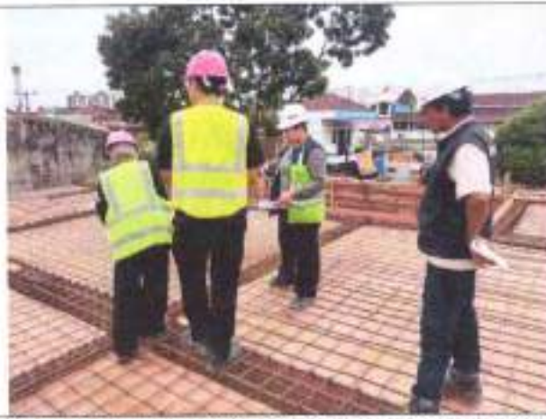
Ceklist bersama pada pekerjaan plat lantai 1 dan balok lantai 1
