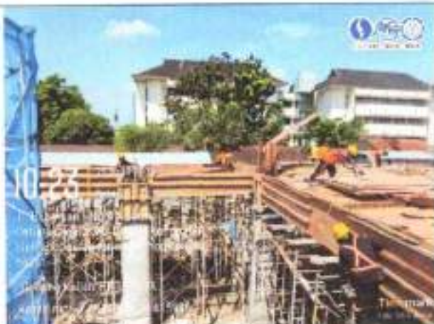
Pekerjaan bekisting balok lantai 1
