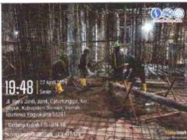
Pekerjaan pengecoran plat lantai dasar
