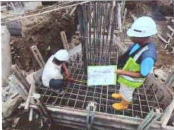
Ceklist bersama pada pekerjaan pilecap
