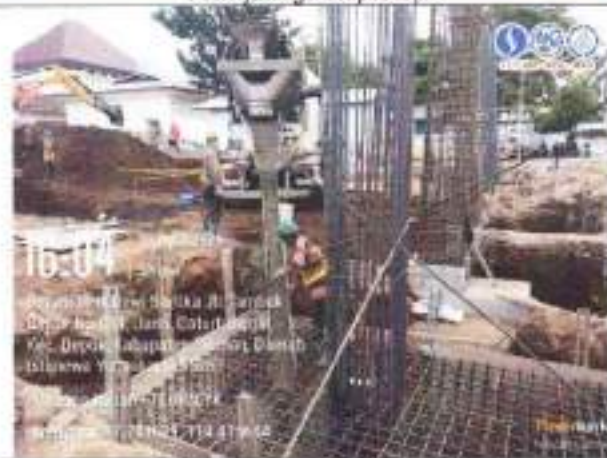
Pekerjaan pengecoran pilecape
