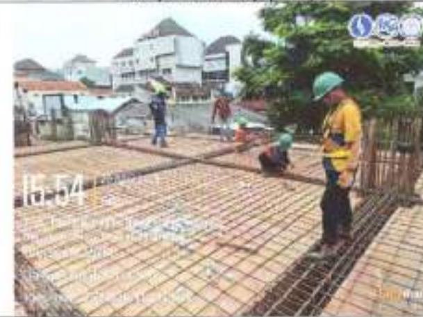
Pekerjaan pembesian plat lantai 1
