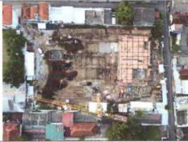
Tampak atas proyek FTI UPN
