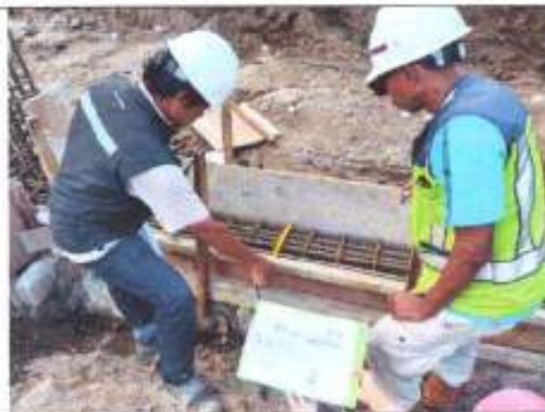
Pengecekan pekerjaan tie beam
