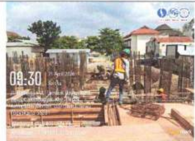
Pekerjaan pembesian balok lantai 1
