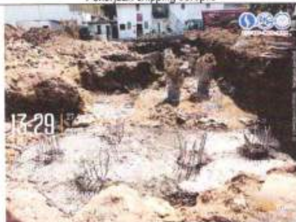
Pekerjaan lantai kerja pilecape
