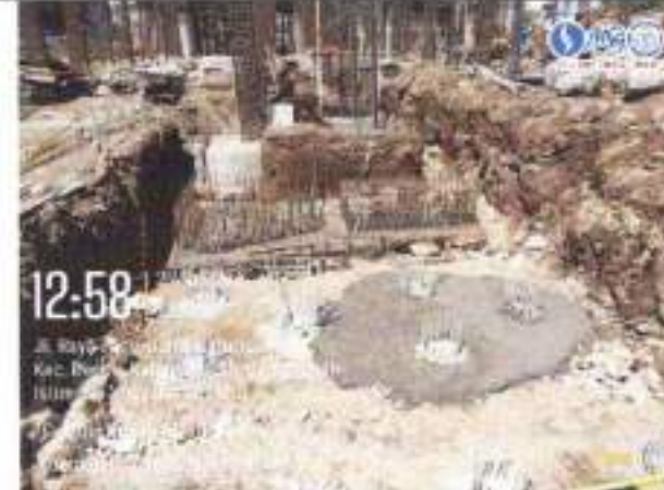
Pekerjaan lantai kerja pilecape
