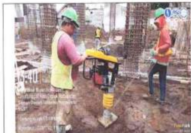
Pekerjaan pemadatan tanah lantai dasar
