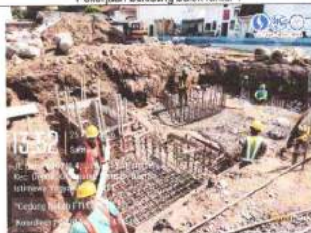
Pekerjaan pembesian pilecape
