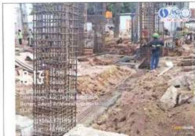
Pekerjaan pembesian tie beam
