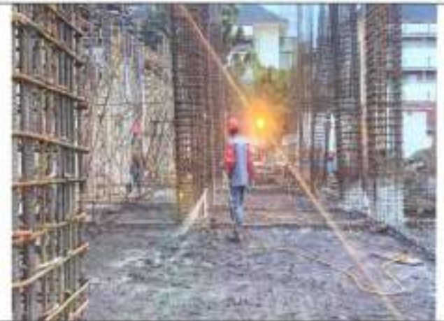
Pekerjaan penyemprotan anti rayap lantai dasar
